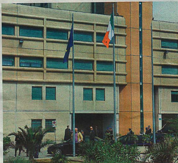
La Casa Circondariale. Ricontrati problemi di carattere igienico-sanitario alla mensa
